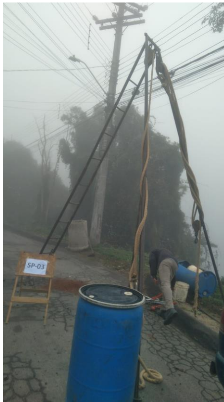
Imagem 3 – Registro do local (durante execução de sondagem a percussão)
