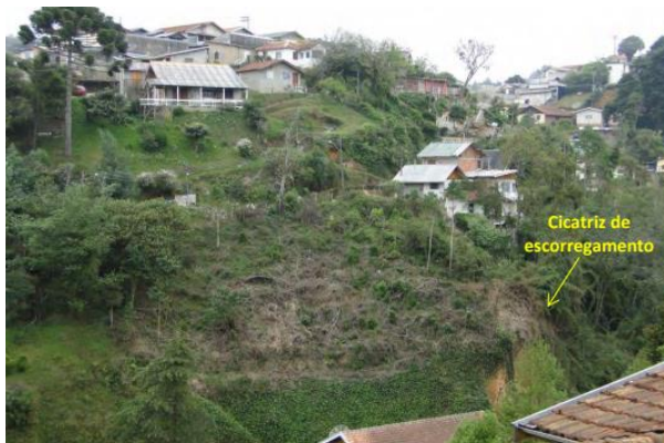
Figura 3 – Área 7 – Vila Fracalanza, observa-se a alta declividade e cicatriz de escorregamento em talude.
