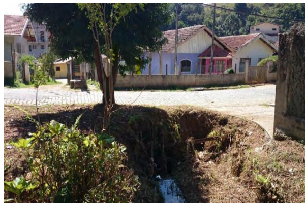
Figura 4 – Área 35 – Vila Ferraz, início da canalização fechada do Córrego do Açude.
